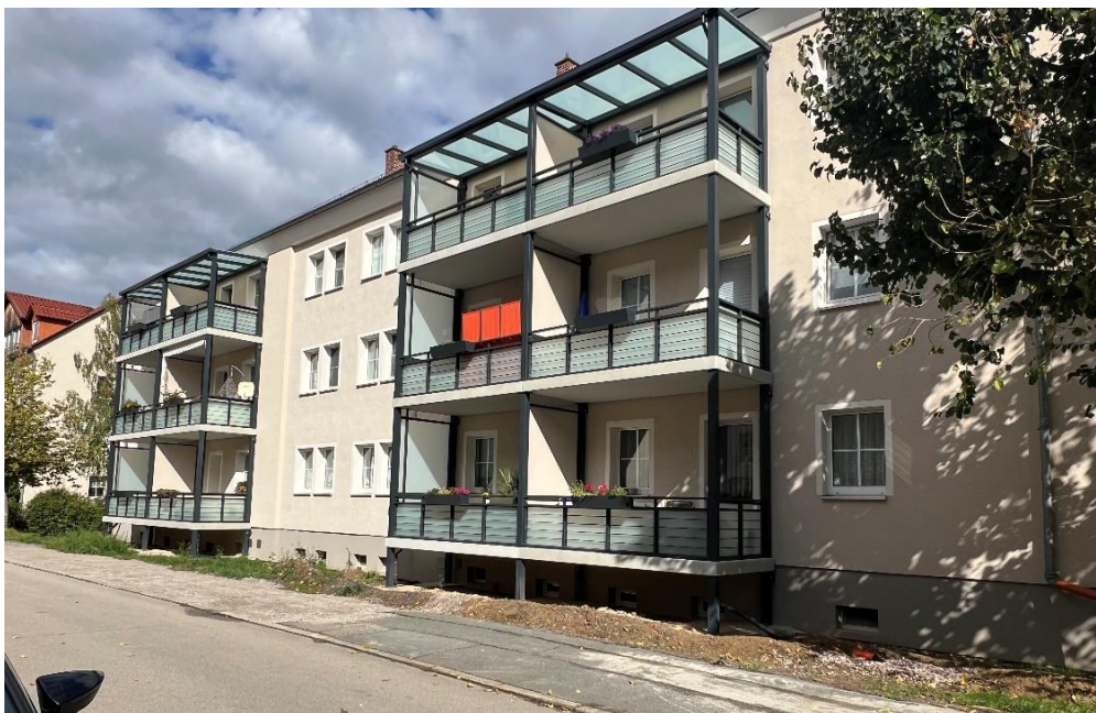
Thomas-Müntzer-Straße 4-6: Balkonanbau nach Fertigstellung
