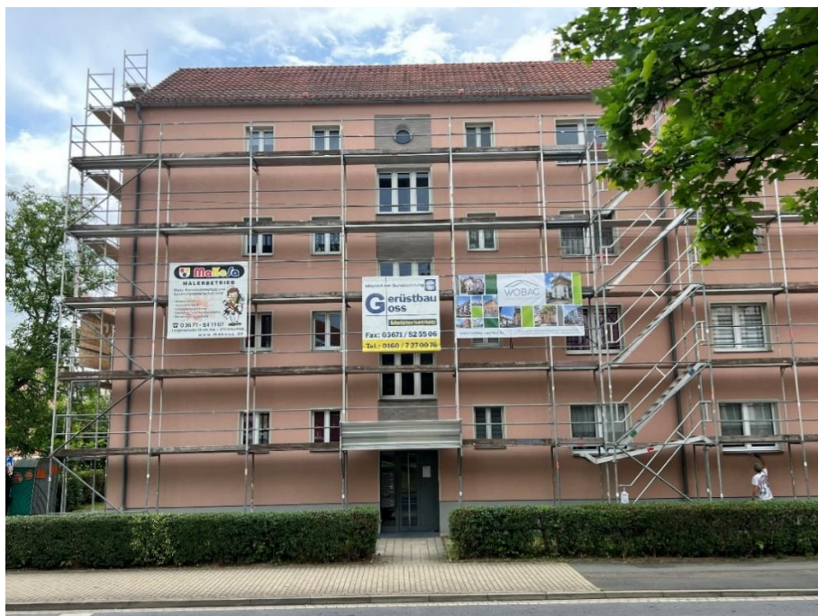
Knochstraße 35 a-b: Erneuerung Fassadenanstrich
